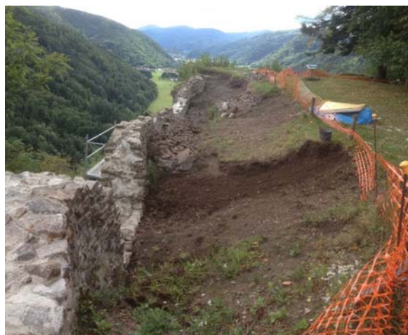
Consolidation du mur "Est"
